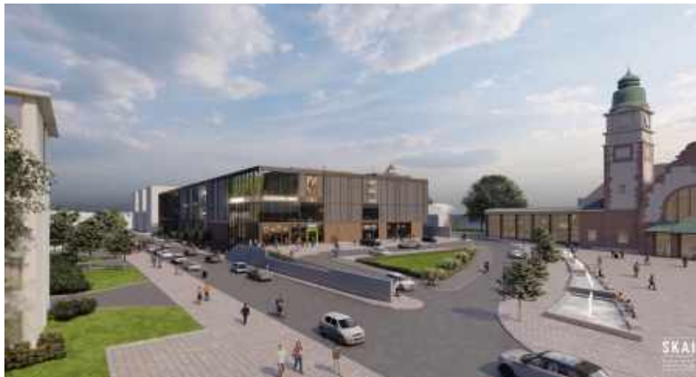
Der Kinopolis-Neubau entsteht an der Basler Straße direkt am Bahnhof von Bad Homburg.
